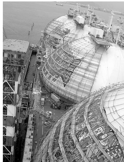
タンク部分への貼付作業
